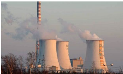
Elektrownia Jaworzno, Polska
